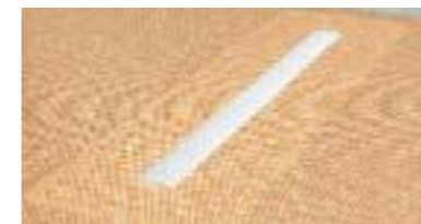
13 Rivestire la restante superficie della doccia con un foglio impermeabile (reperibile in commercio).
