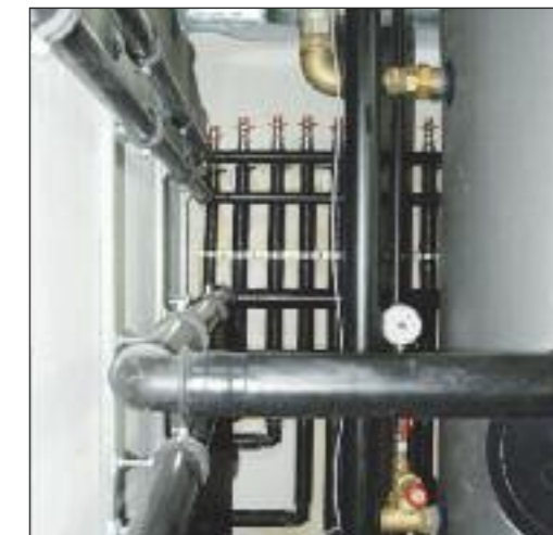
Esempio di centrale termica realizzata con Mepla grandi diametri.
